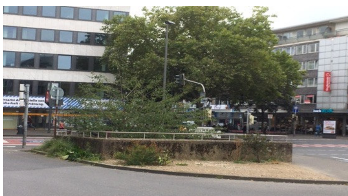
Abbildung: Unschön: Teil der ehemaligen Unterführung an der Peterstraße
