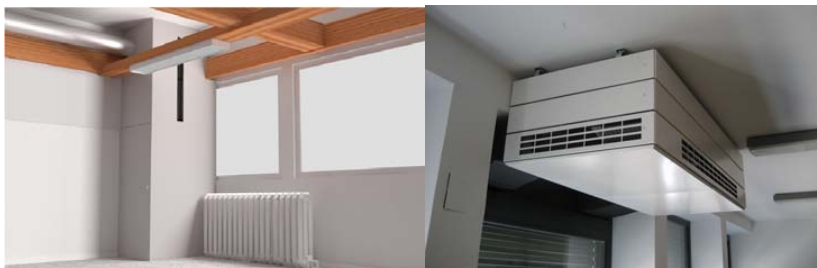
Abb. 15: Lüftungsgeräte als Stand- und Deckenausführung
