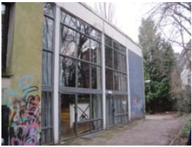
Rhein-Maas-Gymnasium vor der Sanierung Arch. Wasserkampf
