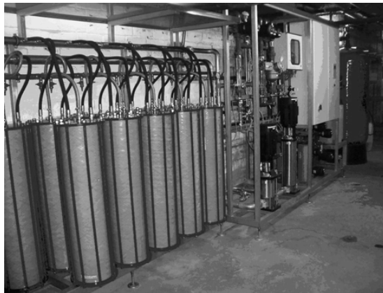
Abb. 27: Membranfiltrationsanlage
