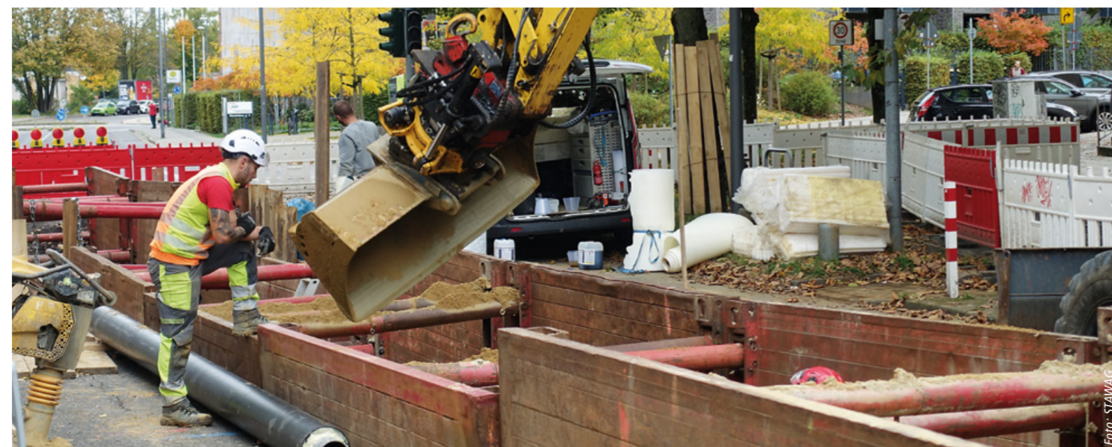
Schreitet voran: Immer mehr Gebiete in Aachen werden mit Fernwärme versorgt.
