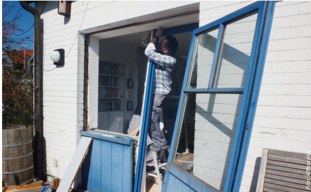
Vor der Sanierung: Unabhängige Beratung, bevor man die Fenster ausbaut.
