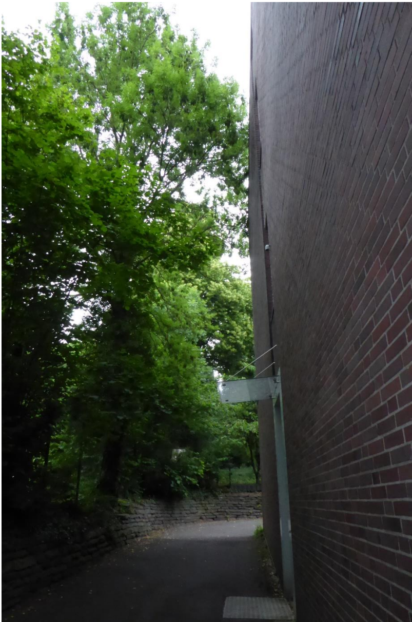
Abbildung 4: Baum Nr. 27, Neigung Richtung Gebäude
