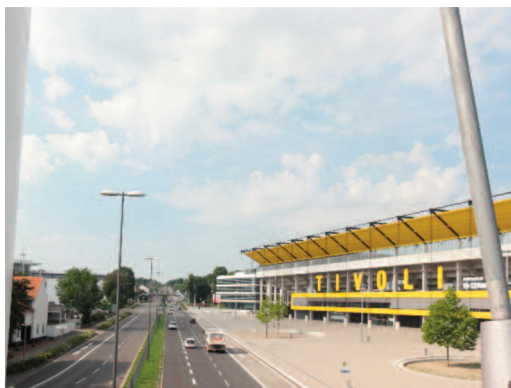
Blick von der Brücke am Tivoli in Richtung zweiter Fußgängerbrücke
