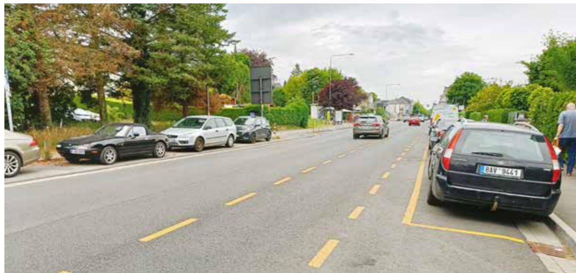
Abb.15: provisorische Markierung Vaalse Straße
