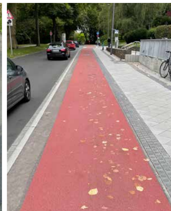
Abb.20: Ludwigsallee vor und nach dem Umbau
