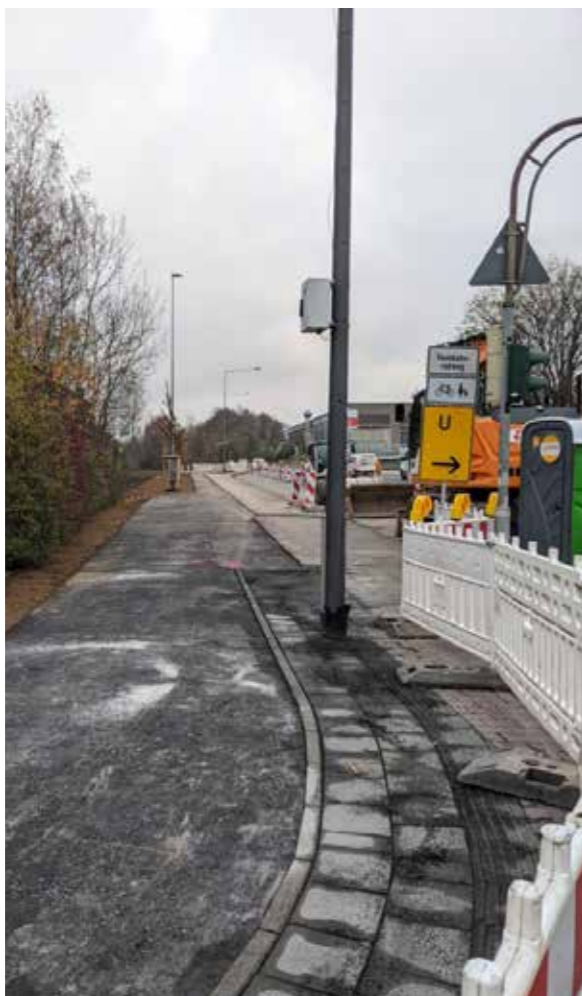
Abb.36: Verkehrsführung während Baustellensituation an der Vennbahn
