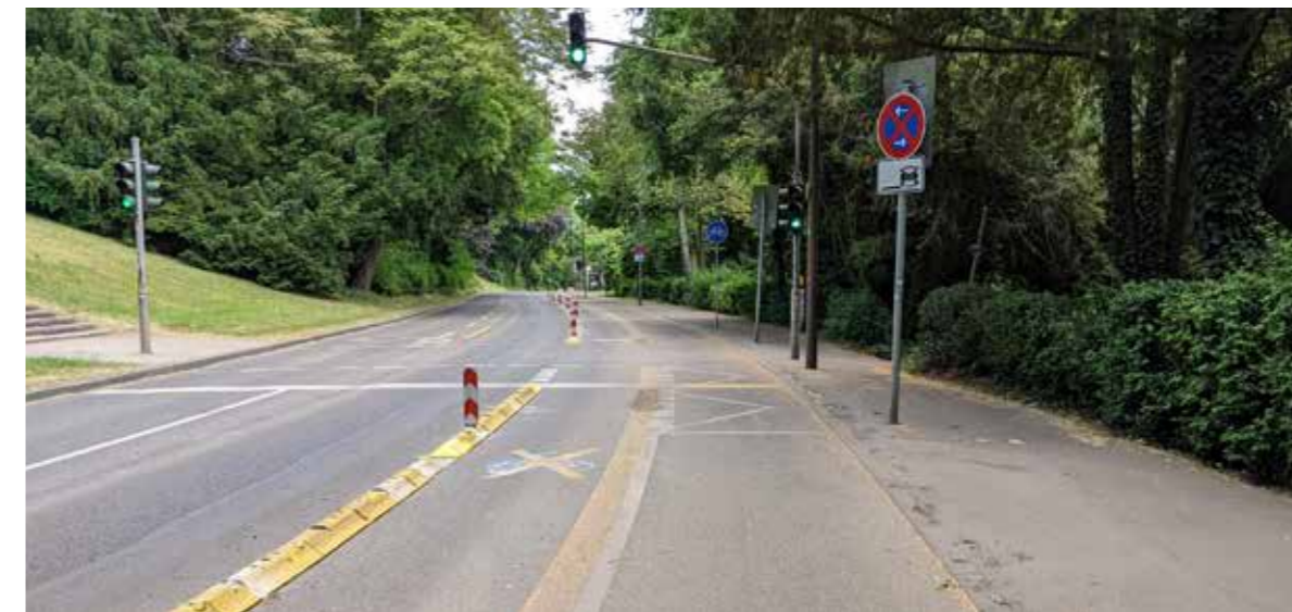
Abb.16: provisorische radentscheidkonforme Protected Bike Lane auf der Saarstraße
