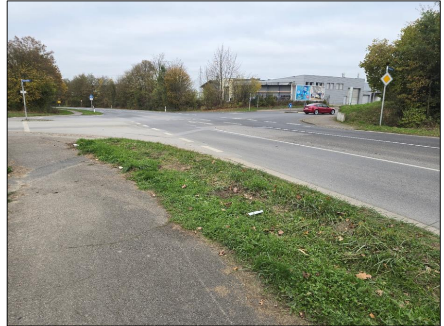
Knotenpunkt Nordstraße/ Eilendorfer Straße/ Sigfeldstraße
