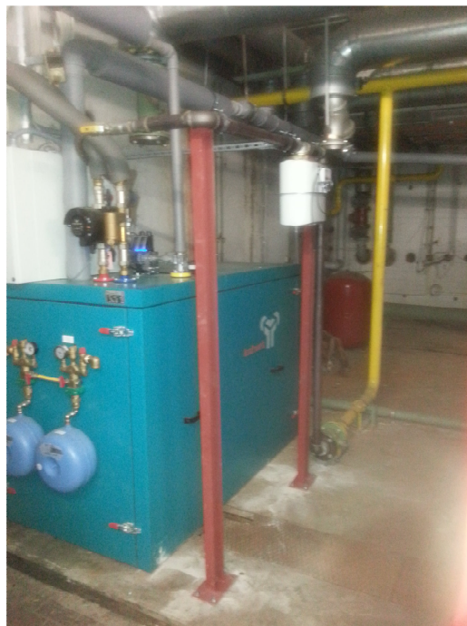
Abb.: BHKW Heizraum (Frontansicht) noch in Bau
