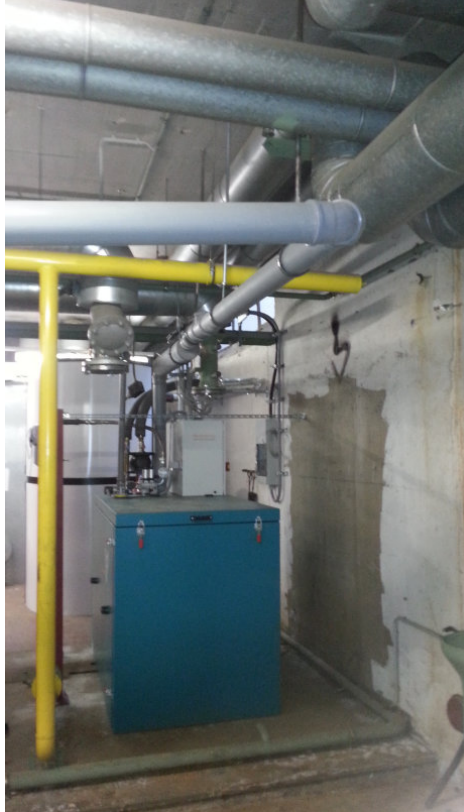
Abb.: BHKW Heizraum (Rückansicht) noch in Bau
