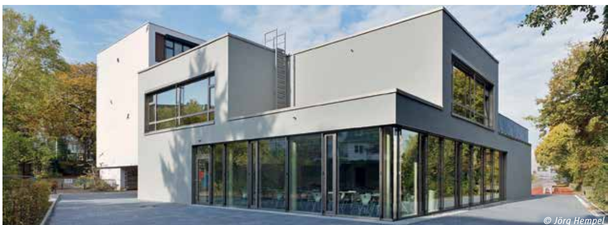
Mensa Rhein-Maas-Gymnasium, Architekten: Hausmann Architekten, Aachen
