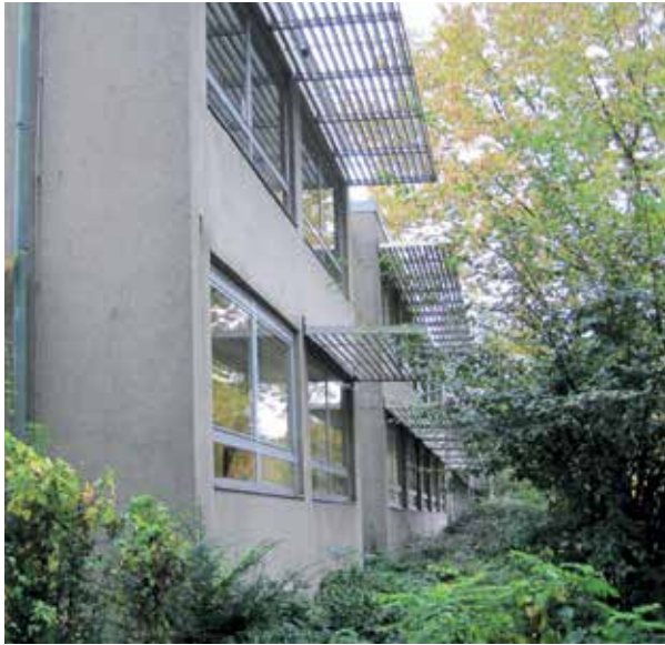
Städt. Gemeinschaftsgrundschule Driescher Hof, Bestand vor Sanierung
