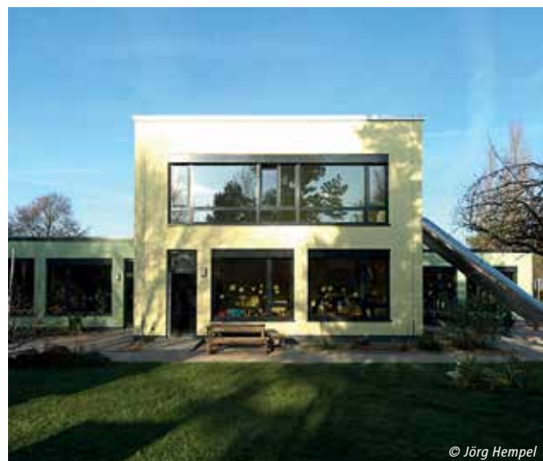
KiTa Brunsumstraße, Architekt: Kessler, Aachen
