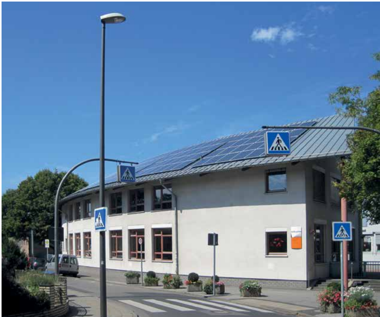
Photovoltaikanlage GGS Richterich
