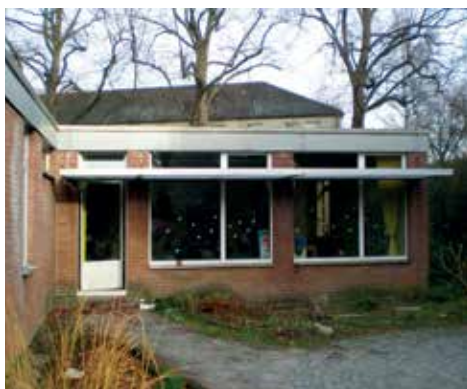
KiTa vor Sanierung
