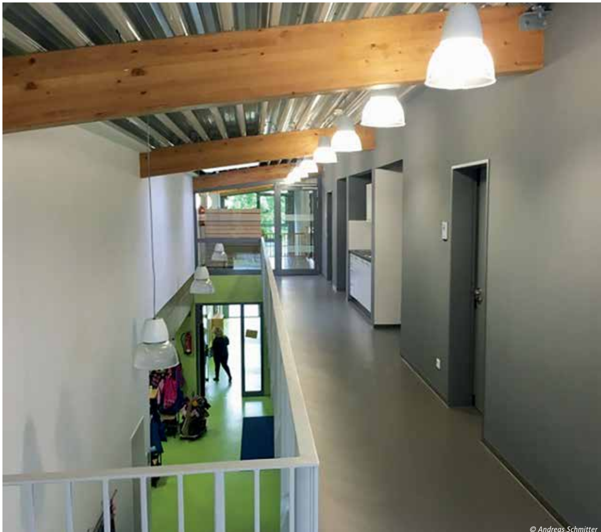
KiTA Sandhäuschen: Galeriebeleuchtung ausgelöst durch Bewegungsmelder im EG
