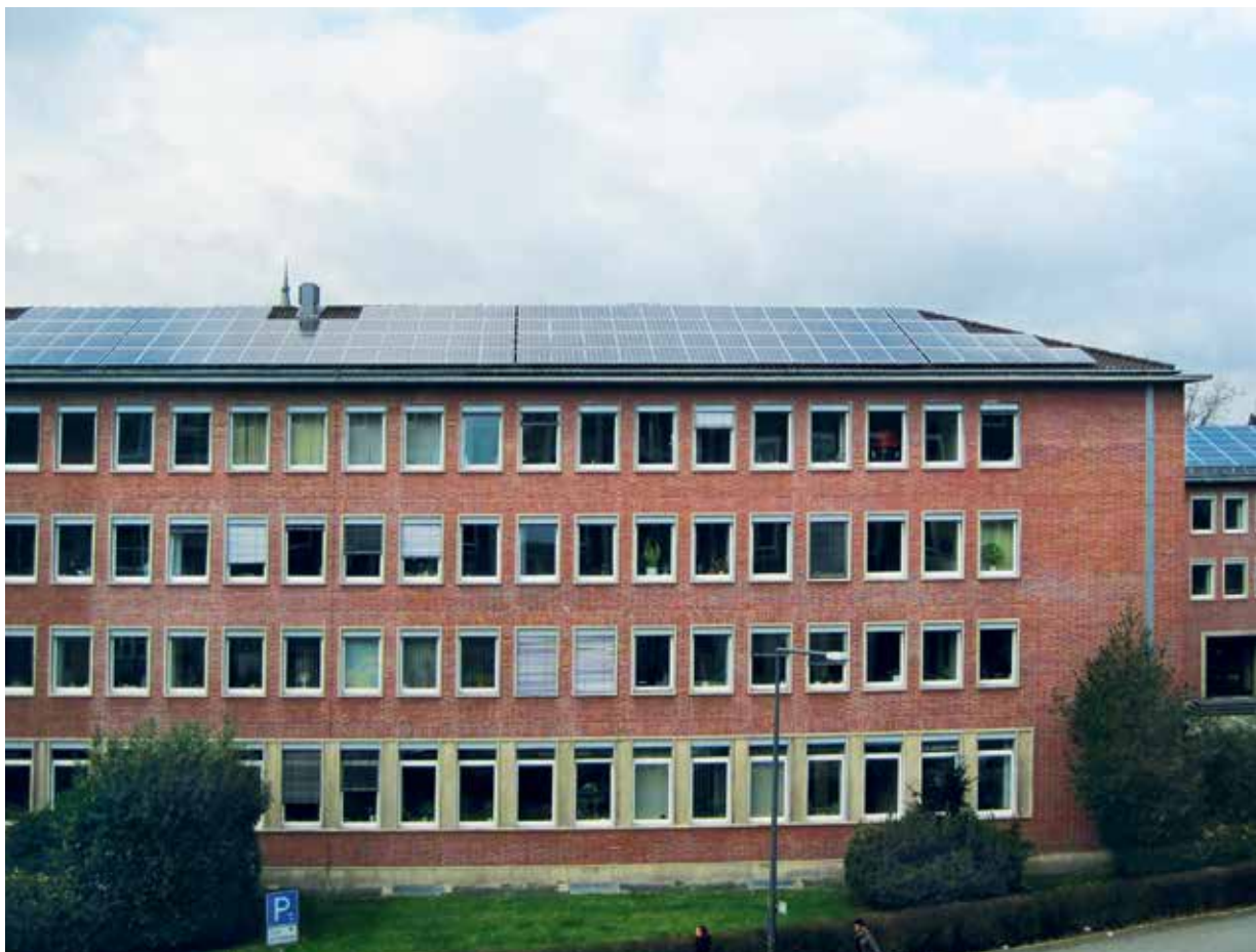
Photovoltaik-Anlage, Verwaltungsgebäude Mozartstraße 2–10
