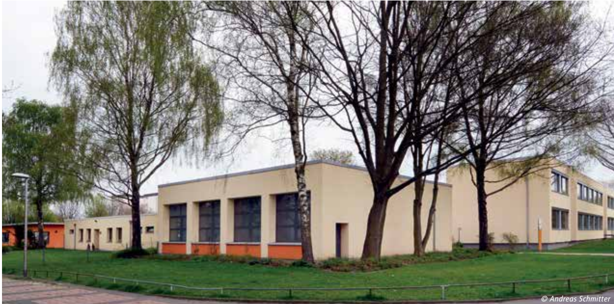
Die thermische Sanierung und die Ertüchtigung der Gebäudetechnik führten zu einer Reduzierung des Wärmeverbrauchs (witterungsbereinigt) von 62%.
