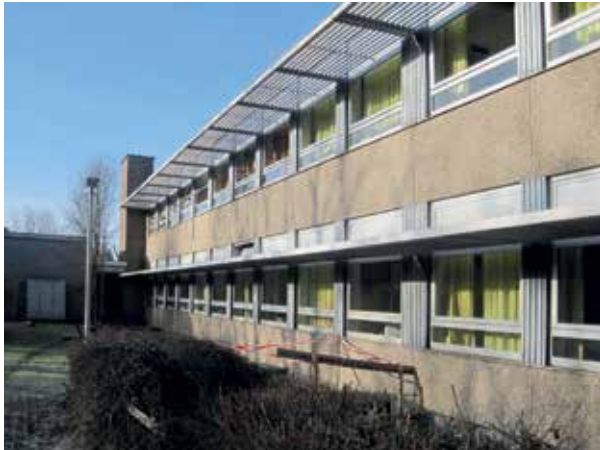
GS Karl-Kuck Fassade vor Sanierung, Architekten: Linie 4, Aachen
