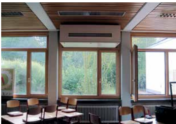
Karl-Kuck-Schule innen und außen, Dezentrale Lüftungsgeräte
