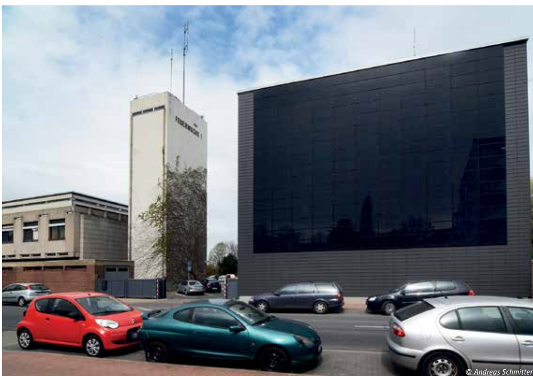
Leitstelle Feuerwache Neubau
