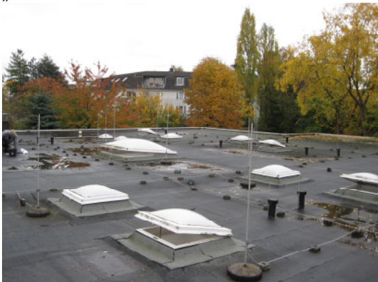
Flachdach in Bestandsgebäude mit Lichtkuppeln
