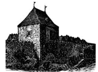
Die Aachener Bäche verließen die Stadt durch den Wasserturm
