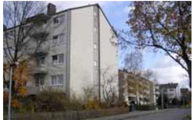
Wohnungsbestände Feldstraße und Zum Kirschbäumchen
