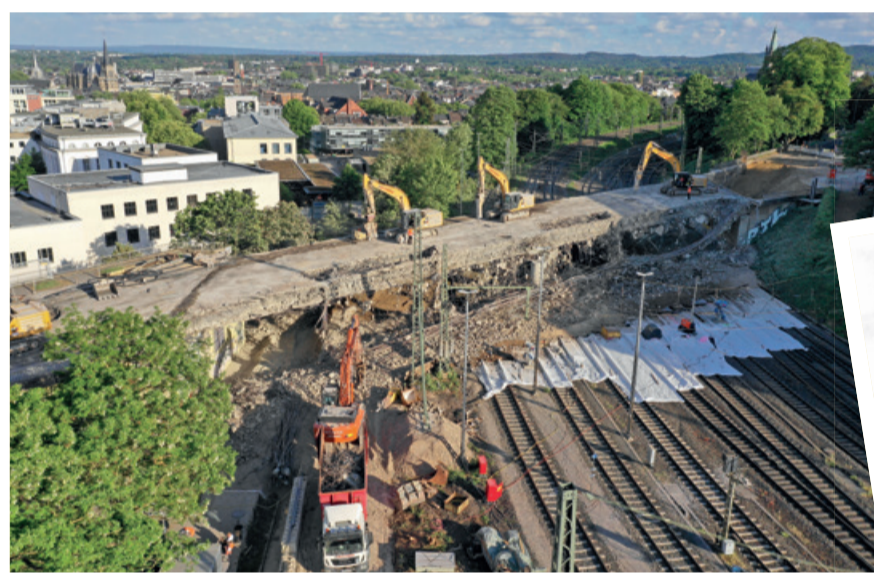
Mammutprojekt: Die Brücke an der Turmstraße wird 2022 abgerissen. Foto: Andreas Steindl
