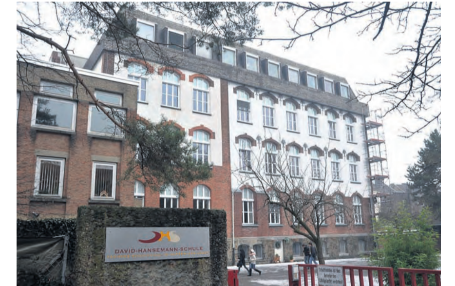
Hier soll die vierte Gesamtschule entstehen: Die David-Hansemann-Realschule.
