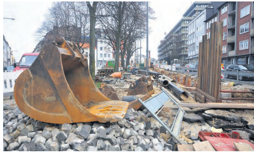
Lagerhausstraße und Boxgraben werden derzeit saniert. Geplante Bauzeit: Bis Oktober 2011.
