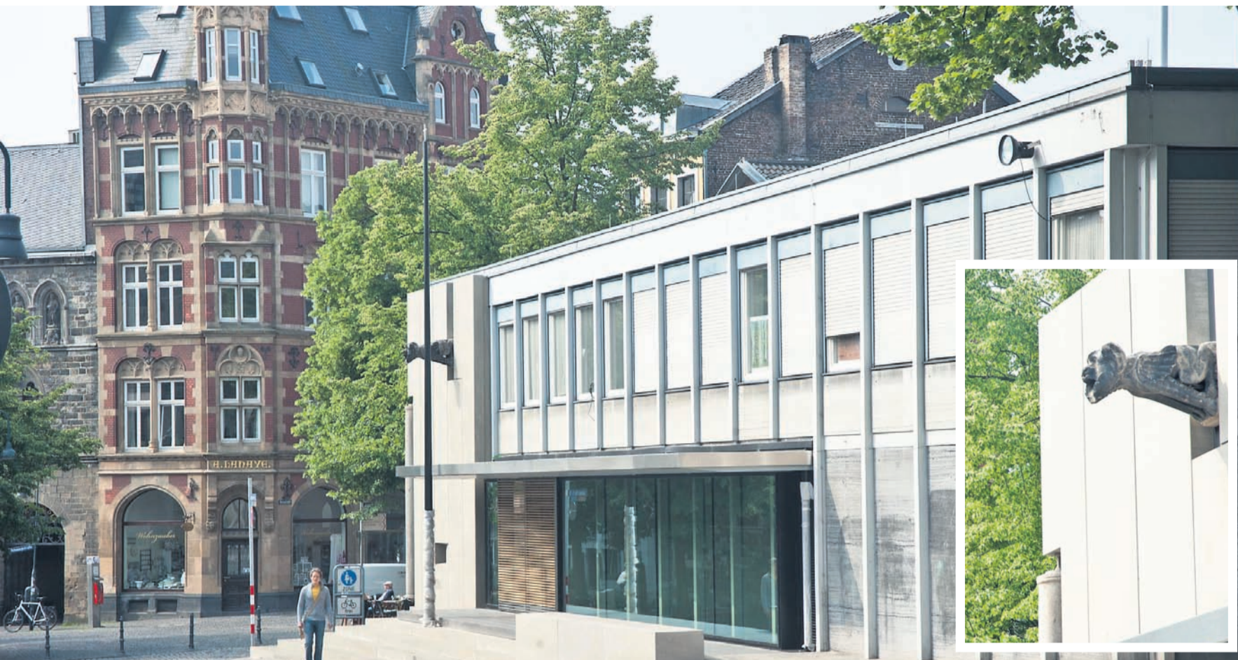
Die neue Domininformation an der Johannes-Paul-II.-Straße, entstanden in der ehemaligen Poststelle.
