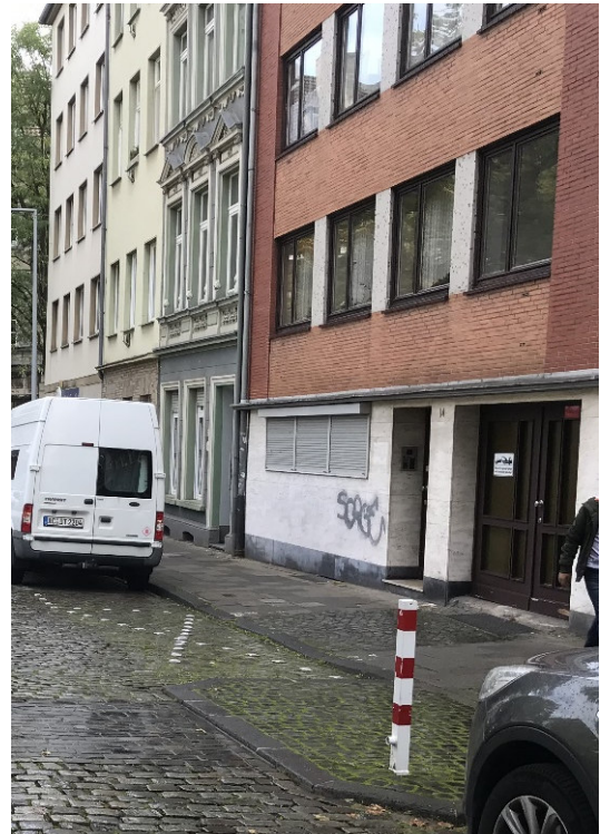
Abbildung 11: Querneigung und Gehwegabsenkung am Rehmplatz
