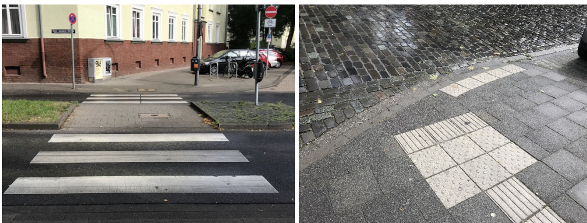
Abbildung 5: Querungshilfe ohne (Hein-Janssen-Straße, links) und mit barrierefreier Ausstattung (Rehmplatz, rechts)
