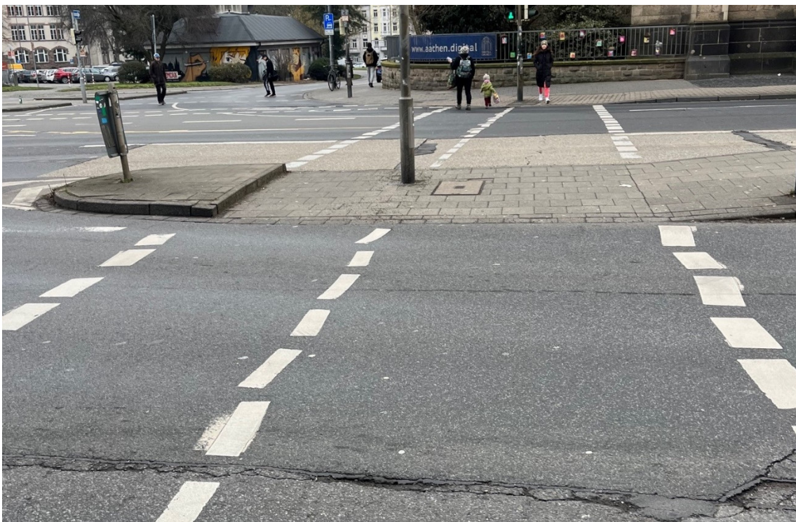
Abbildung 25: Lichtsignalanlage Jülicher Straße/Blücherplatz
