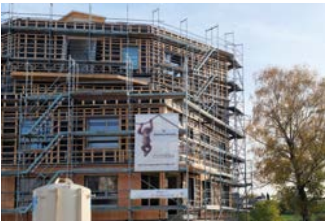
Abbildung 68: Baustelle Wohnprojekt Wiesental. Bildnachweis: Stadt Aachen/Martin Jordan
