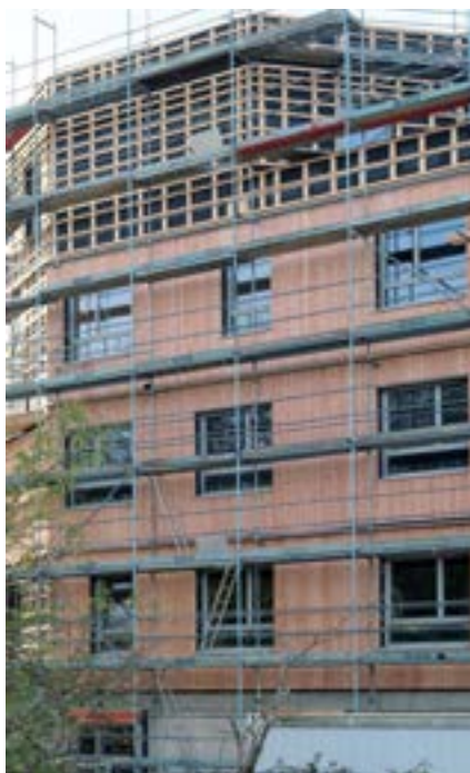
Abbildung 69: Baustelle Wohnprojekt Wiesental. Bildnachweis: Stadt Aachen/Martin Jordan
