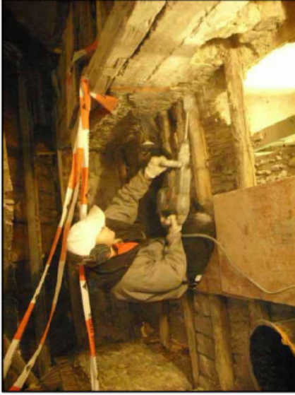
Setzen der Bohrlöcher
