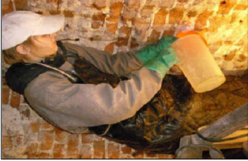
Bohrlochränkung (Lochnertor)
