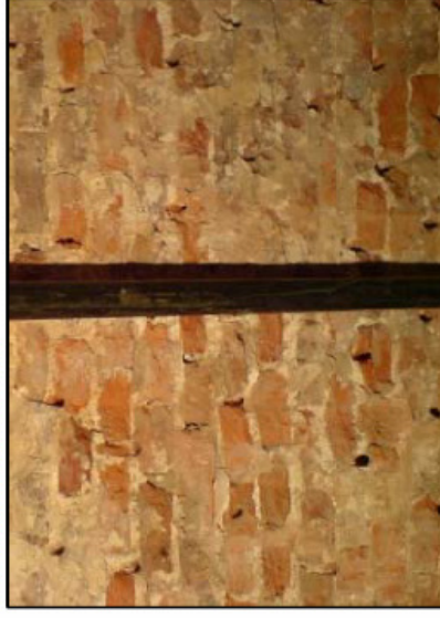
Setzen der Bohrlöcher
