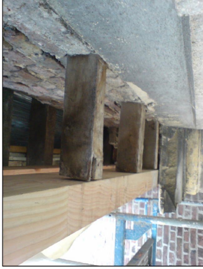
Träger mit auskragenden Stichbalken
