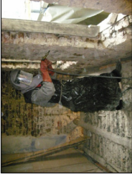
Tränkung durch Druckinjektion (Kutscherhaus)
