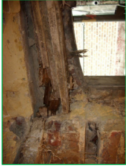
Strangmyzelien an Fenster/Türsturz des Ku-Hauses
