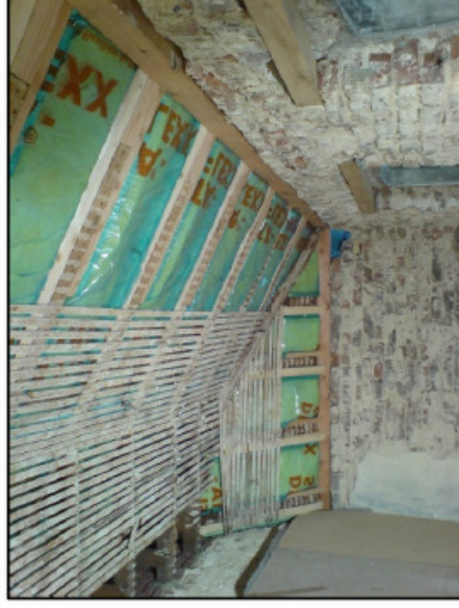
während der Arbeiten
