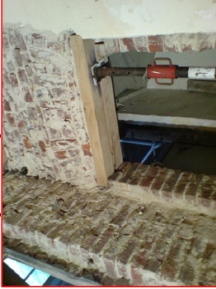
Detail Auflager mit Unterlegkeil
