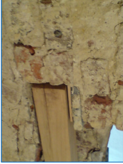
Detail Auflager mit Unterlegkeil
