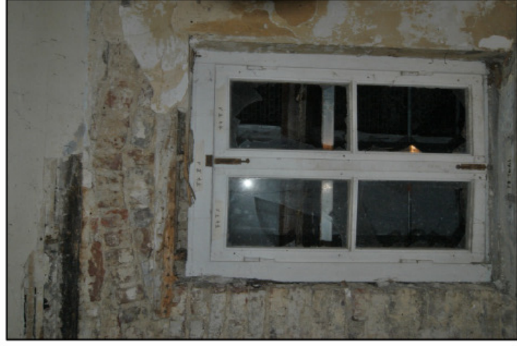
Element: Blendrahmenfenster im Obergeschoss des Kutscherhauses
