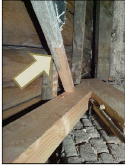
Fußpunkt: Windrispe angeblattet (Pfeil)
