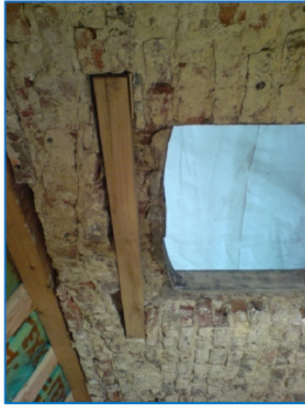
Vorzustand: zerstörte Stürze
