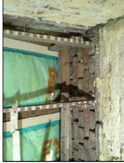
Firstbereich mit erhaltener Schwelle
