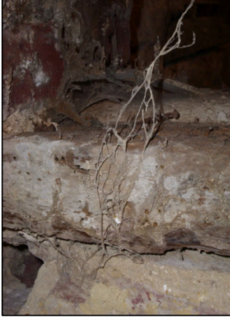
Strangmyzete des wilden Hausschwammes im Detail
