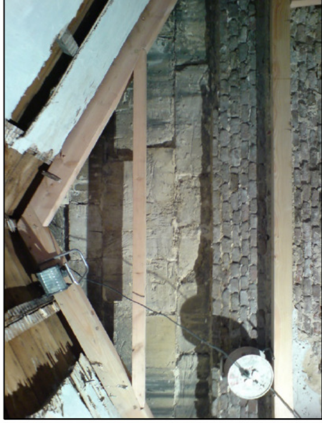
Situation während der Arbeiten
