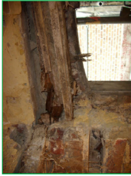
Vorzustand: zerstörte Stürze
