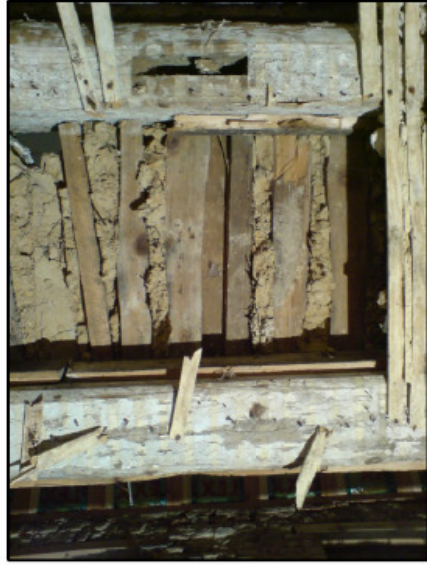
erhaltener Rest des ehem. Deckeneinschubes
