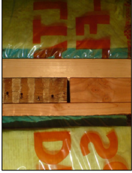
Detail: Dämmung, alter Sparren, Begleitsparren
