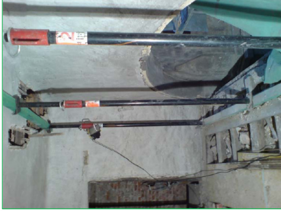
Abstützung der Decke im Lochnertor
