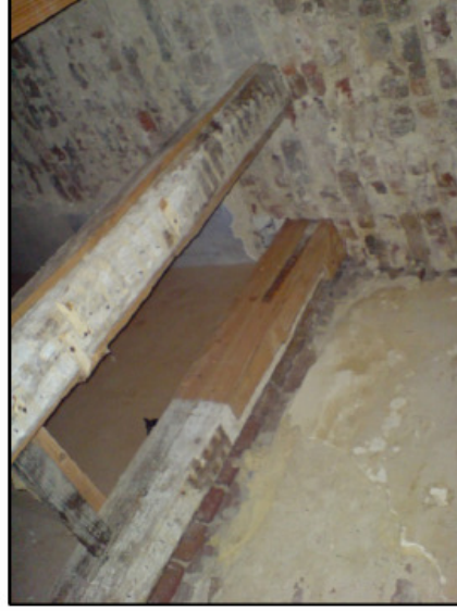
Reparaturverbindung
