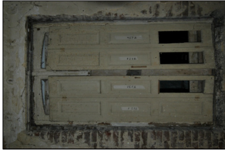
Element: mehrflügelige Schlagläden im Erdgeschoss des Kutscherhauses
