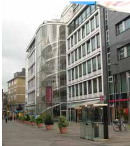
Abbildung 16 Expressives Treppenhaus am Dahmengraben
