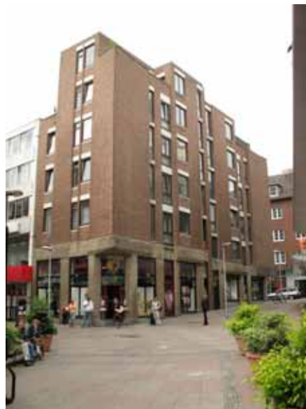
Abbildung 17 Gebäude Klappergasse 11 (Arch. Reihs)
