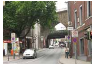
Abbildung 22 Bahnbrücken in der Königstraße
