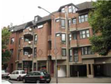
Abbildung 19 Gebäude an der Neupforte
