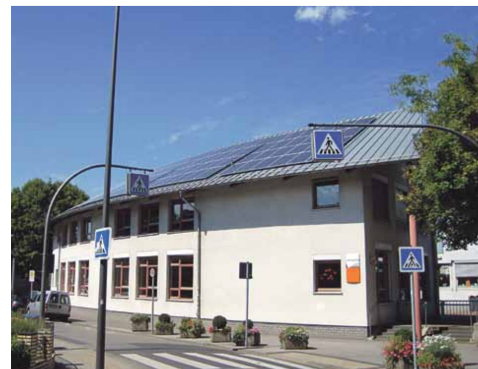
Bürgersolaranlage auf der Grundschule in Richterich
