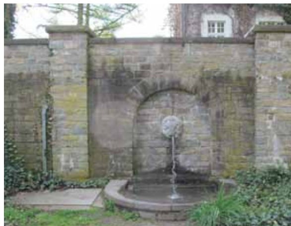
Abb.89 Natursteinmauer mit Wandbrunnen im Rosengarten
