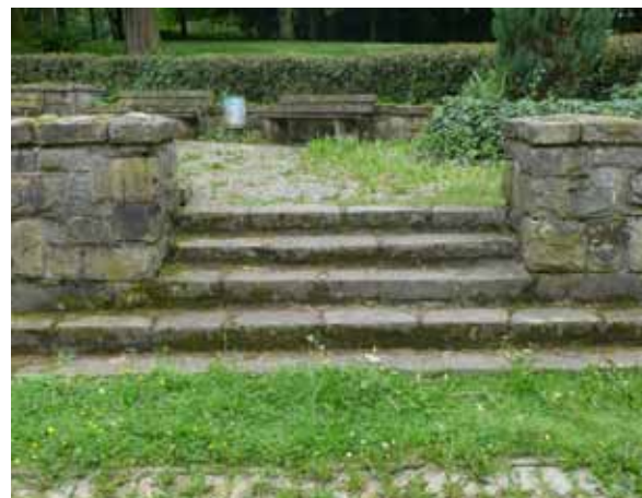
Abb.90 Mauern und Treppen am Halbrondell im Farwickpark
