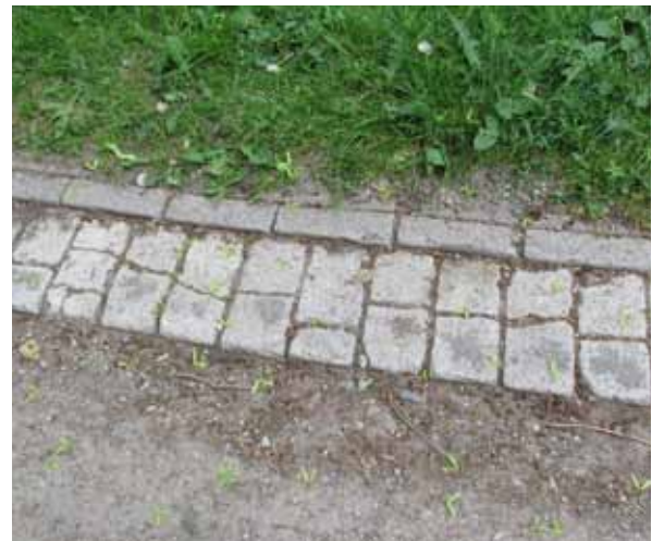
Abb.85 Charakteristische Einfassung der Wege, häufig defekt
