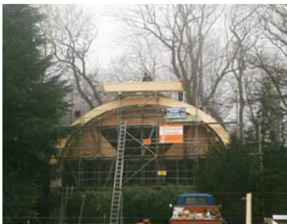
Abb.42 Sanierung Konzertmuschel, Foto, Stadt Aachen 1993
