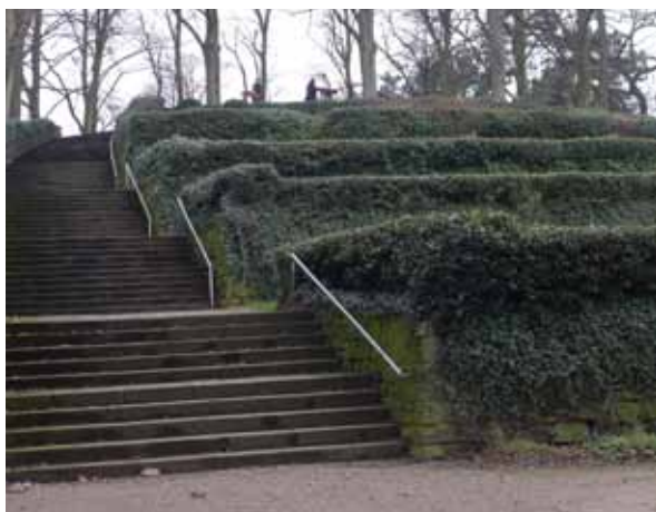
Abb.91 Mauern und Treppen an den Blumenterrassen im Farwickpark
