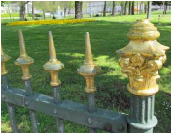
Abb.96 Einfriedung an der Monheimsallee
