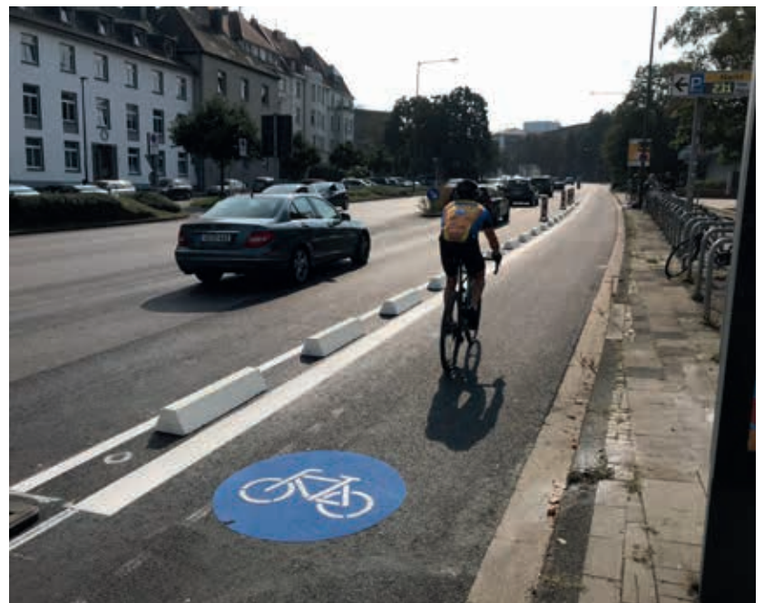
Abbildung 16 und 17: Protected Bike Lane auf dem Pontwall vor (links) und nach (rechts) dem Einbau
