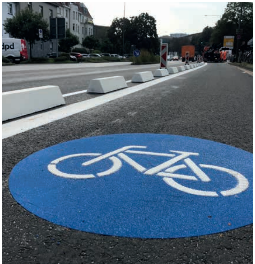
Abbildung 12: Protected Bike Lane auf dem Pontwall
