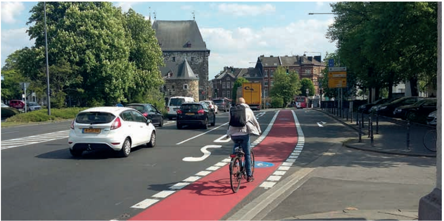
Abbildung 24: Neu markierter Schutzstreifen auf der Roermonder Straße in Richtung Ponttor
