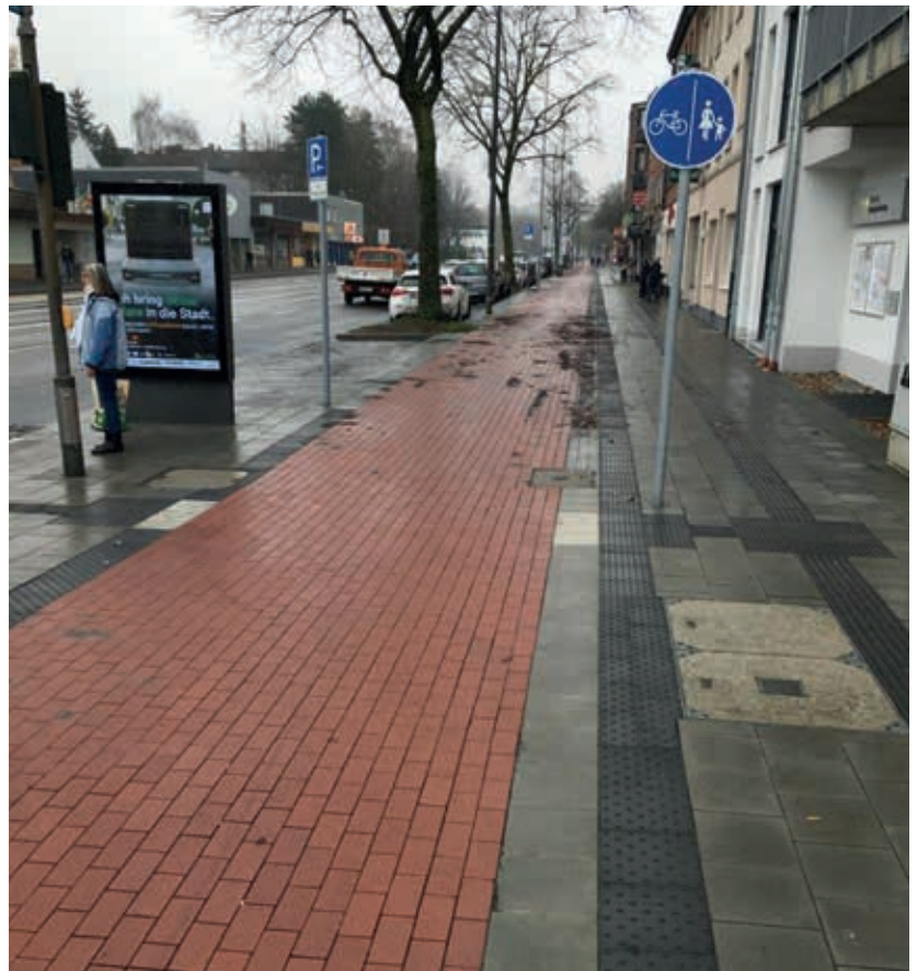
Abbildung 10 und 11: Baulich getrennter Zweirichtungsradsradweg auf der Trierer Straße.
