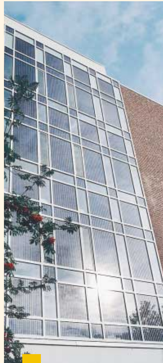
Solarfassade STAWAG Zonne-energie op gevel STAWAG Façade à photovoltaïque STAWAG Solar facade STAWAG (Public Utilities Company)
