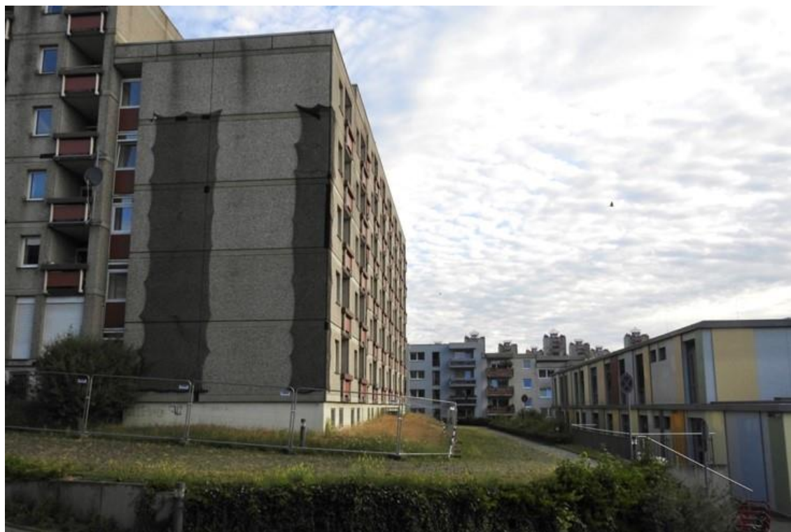
Abbildung 3: Mehrgeschossiger Plattenbau der Klinikverwaltung. Blick Richtung Norden.
