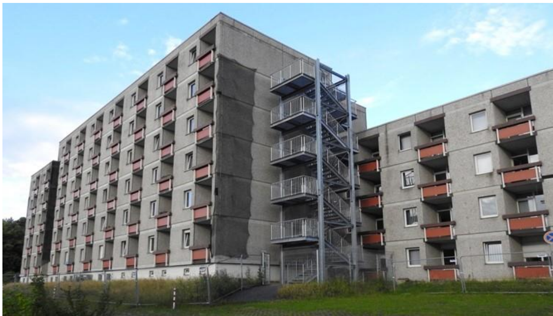
Abbildung 7: Plattenbau der Klinikverwaltung. Blick Richtung Norden.
