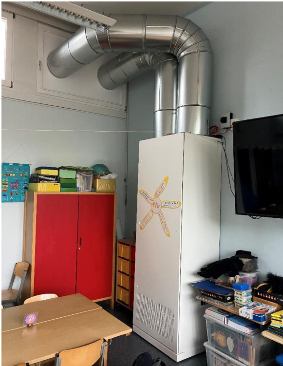
Abbildung 8: Beispiele für Lüftungsanlagen in Klassenzimmern (Quelle: Stadt Aachen)
