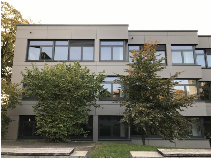
Abbildung 29: Inda-Gymnasium vor und nach der Sanierung (Quelle: Stadt Aachen)
