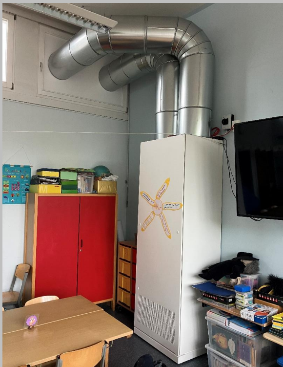
Abbildung 13: Beispiele für Lüftungsanlagen in Klassenzimmern (Quelle: Stadt Aachen)
