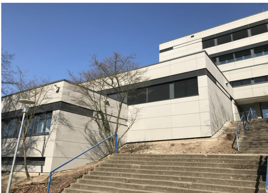
Abbildung 25: Einhard-Gymnasium vor und nach der Sanierung (Quelle: Stadt Aachen)
