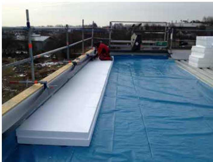
Bei der nachträglichen Dämmung von Flachdächern muss meist auch der Dachrand (Attika) erhöht werden
