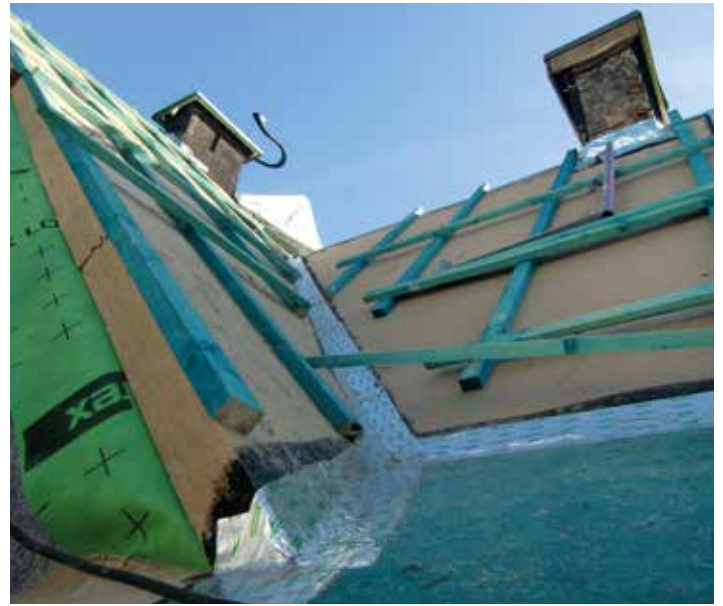
Dämmung auf den Sparren, hier mit Holzfaserplatten (Sanierung von außen)
