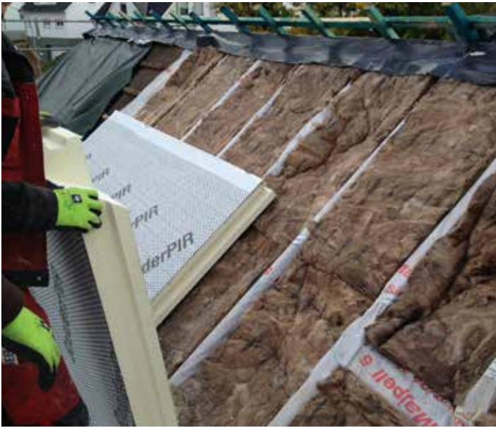
Dämmung zwischen und zusätzlich auf den Sparren (Sanierung von außen)
