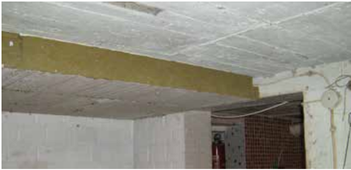
Dämmung der Kellerdecke von unten
