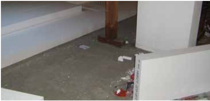
Zweilagige Dämmung eines Speicherbodens
