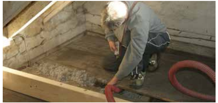
Dämmung einer Holzbalkendecke durch Einblasen von Zelluloseflocken
