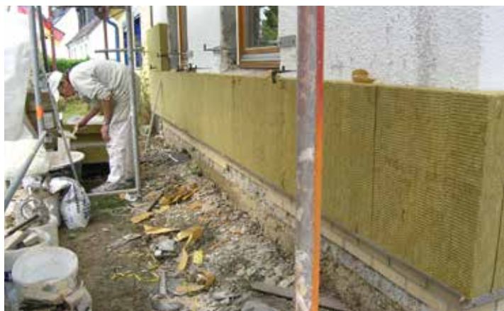
Wärmedämmverbundsystem mit Mineralwolle vor dem Verputzen
