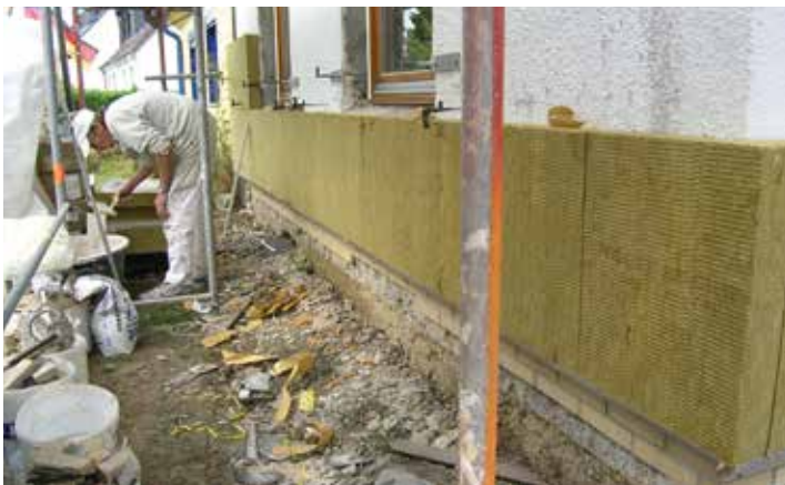
Wärmedämmverbundsystem mit Mineralwolle vor dem Verputzen
