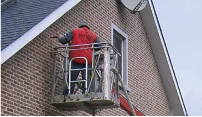
Nachträgliche Kerndämmung: Der Hohlraum hinter den Klinkern wird mit Dämmstoff verfüllt.
