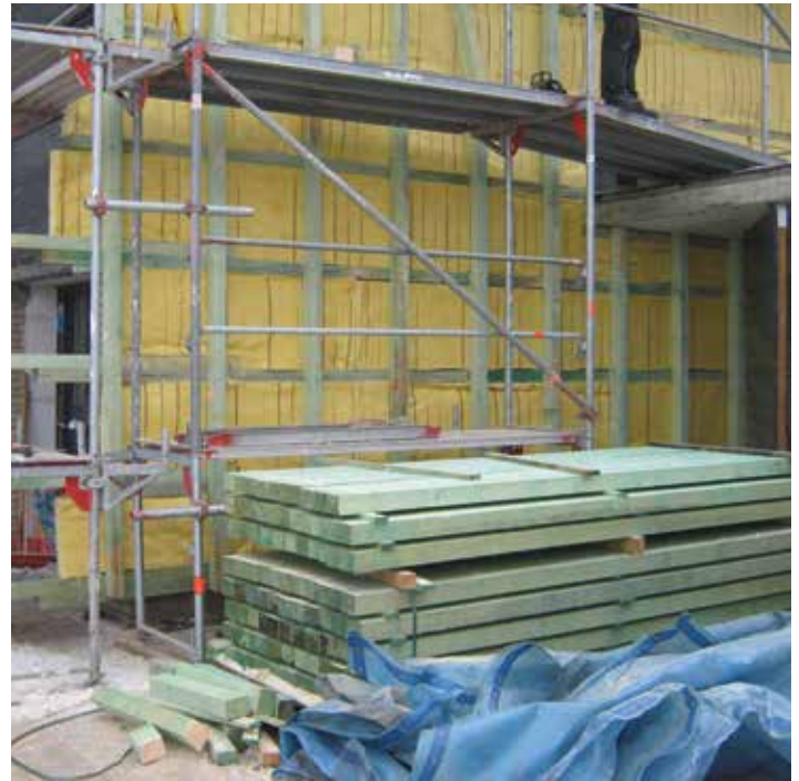
Vorhangfassade vor dem Anbringen der 2. Dämmstofflage und der abschließenden Verkleidung („Vorhang“)
