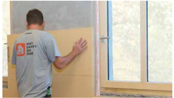
Anbringen einer Innendämmung, hier mit Holzfaserplatten.
