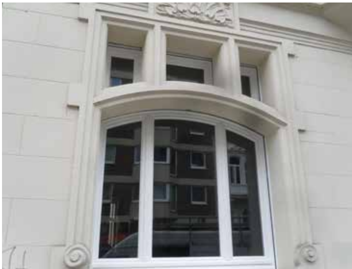
Neues Fenster in altem Haus
