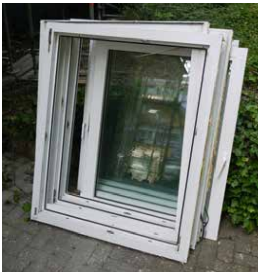
Fenster mit alter Doppelverglasung (vor 1995) sind oft schon sanierungsbedürftig.
