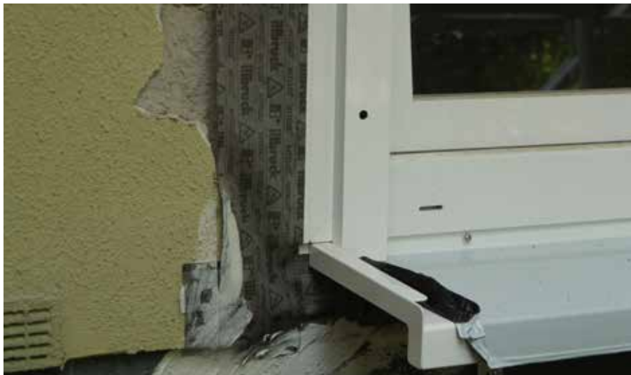
Nach außen versetztes, neues Fenster mit Dichtungsfolie. Hier wird anschließend eine Außenwanddämmung ergänzt.
