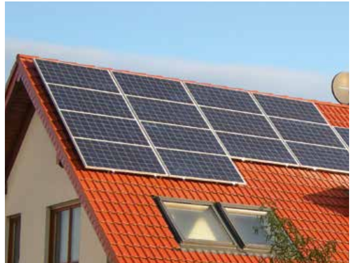
Photovoltaik-Module zur Erzeugung von Strom
