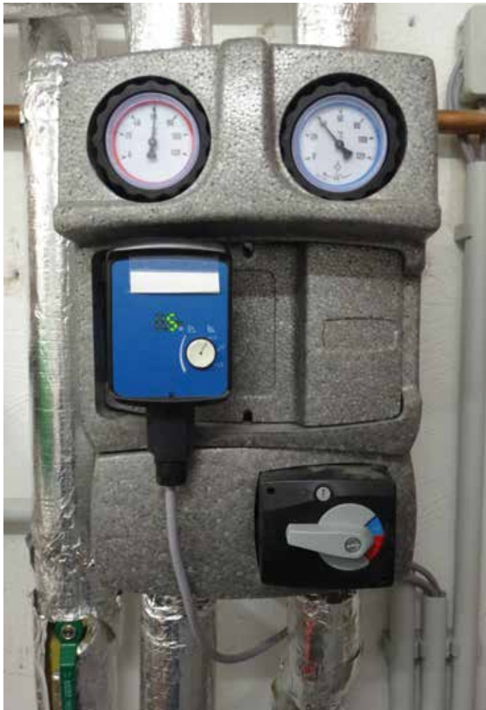
Moderne Umwälzpumpe (aktuelle Leistung: 5 Watt)
