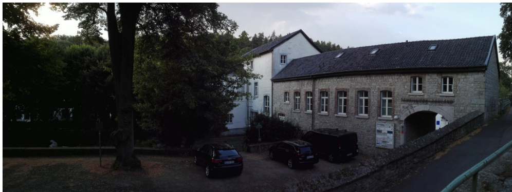
Tuchfabrik Rohland (Blick von Promenade – Klauser Straße)
