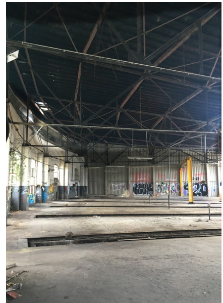
Abb. 65: Lokhalle mit Wartungsgruben
