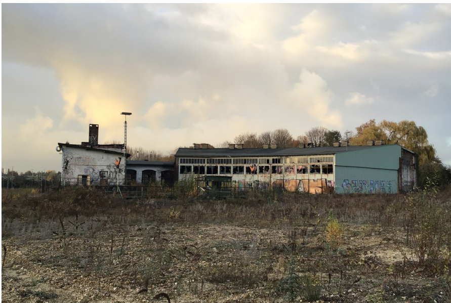
Abb. 66: Lokhalle mit Drehscheibe
