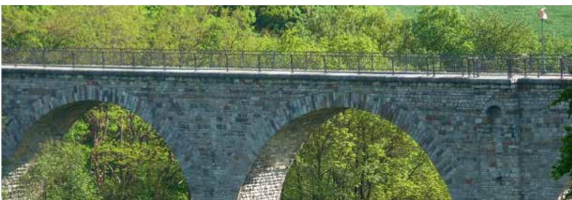
Viadukt Brand/ Vennbahnweg
