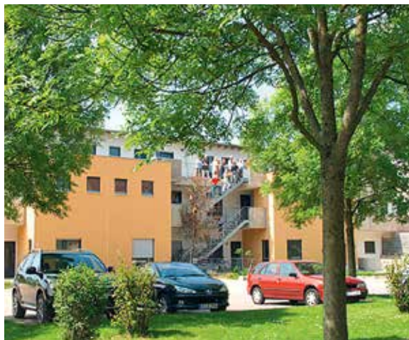
Mit Freu(n)den unter einem Dach, Wohnprojekt in Brand
