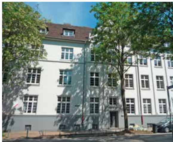
links: Energetische Sanierung Kindergarten Höfchensweg
