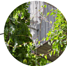
Rückseitige Fassaden- begrünung
