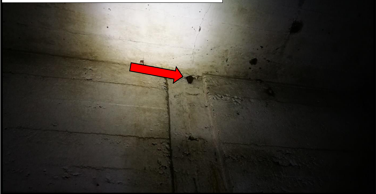
Überwinternde Zwergfledermaus im Keller des Bunkers
