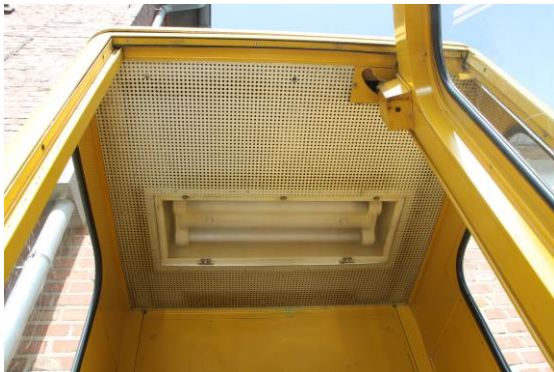
Abb. 3: Decke mit Lochblech und Beleuchtung (Verf.03.05.2018)
