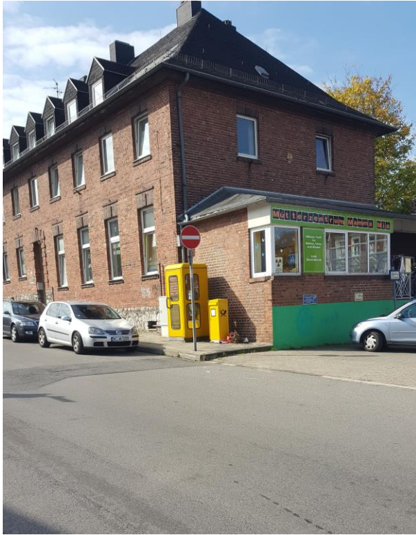
Abb. 1: FeH 78 Standort Püngelerstraße / Ecke Vaalser Straße, Ansicht von Nordosten (Pavlovic 26.09.2017)
