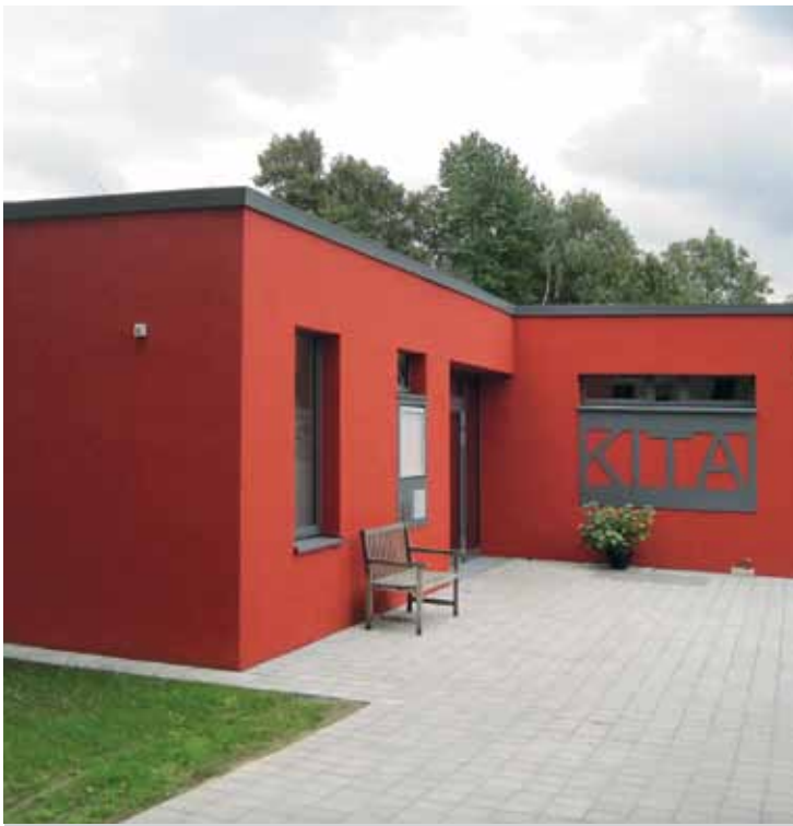
Kita Am Höfling, Beispiel Wanddämmung Thermohaut
