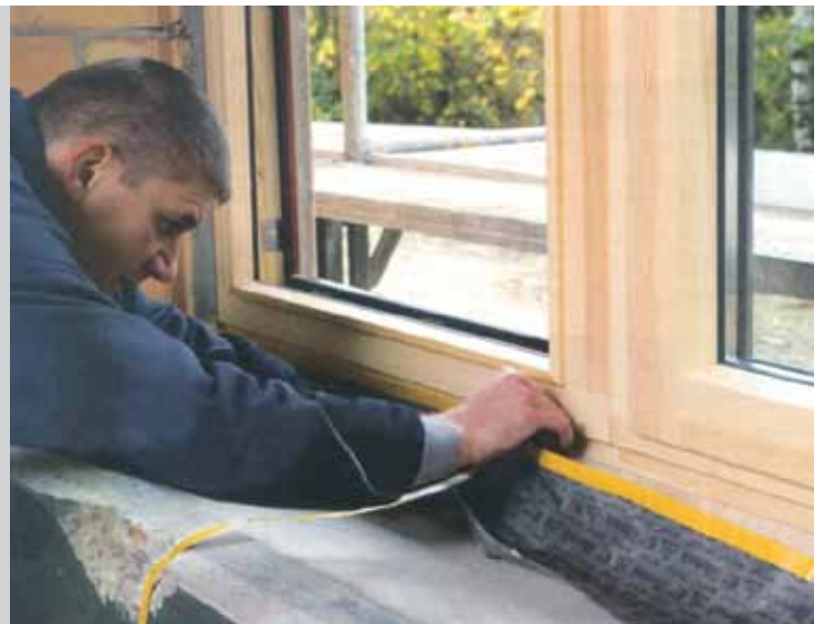
Fenstereinbau mit Dichtfolie
