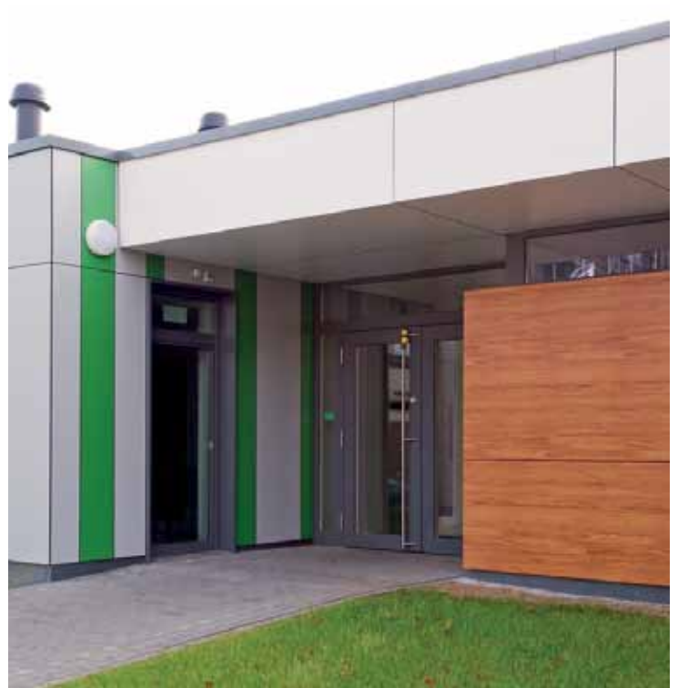
Kita Stolberger Straße 126, Beispiel Trespa-Fassade
