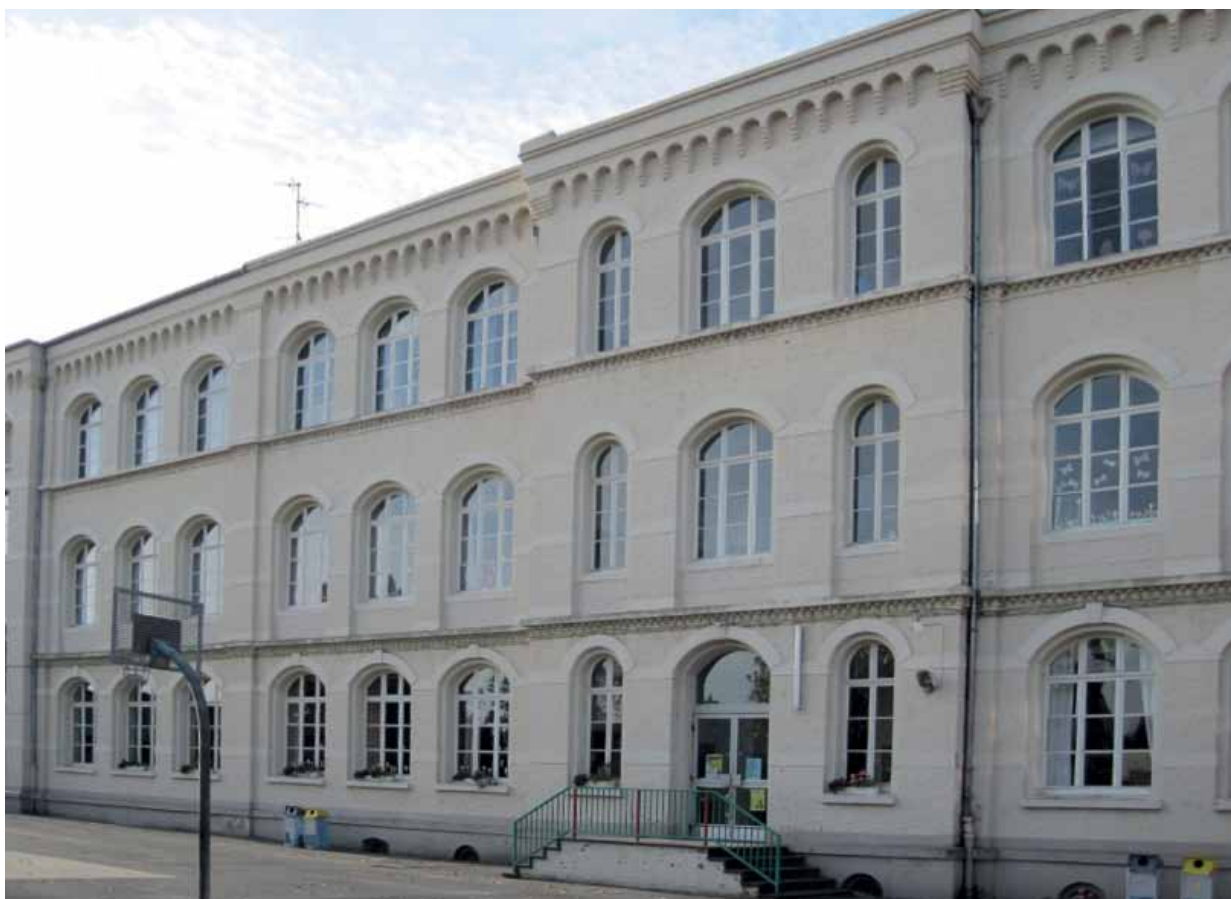
Baudenkmal Grundschule Michaelsberg
