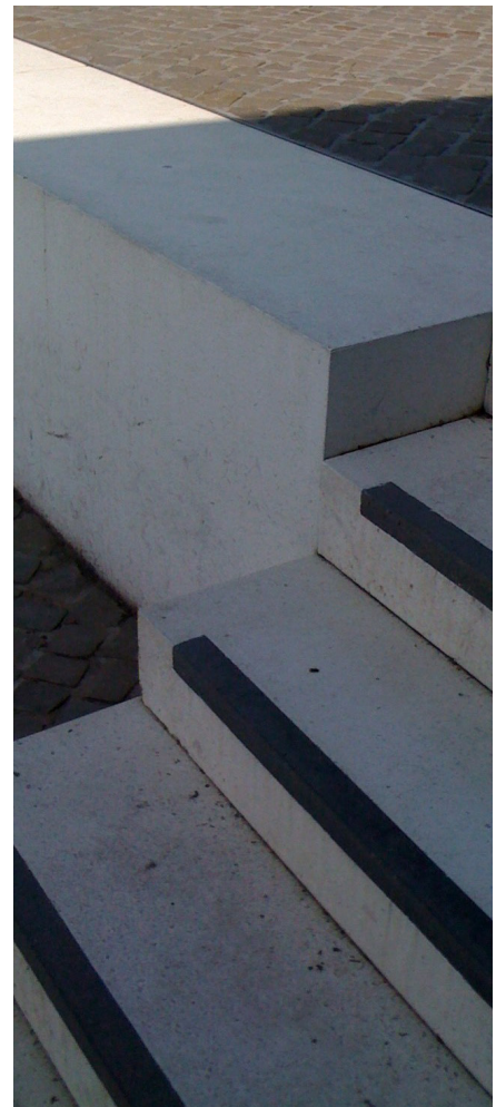
Abb. 18: Stufenbauweise mit eingelegten Markierungsstreifen
