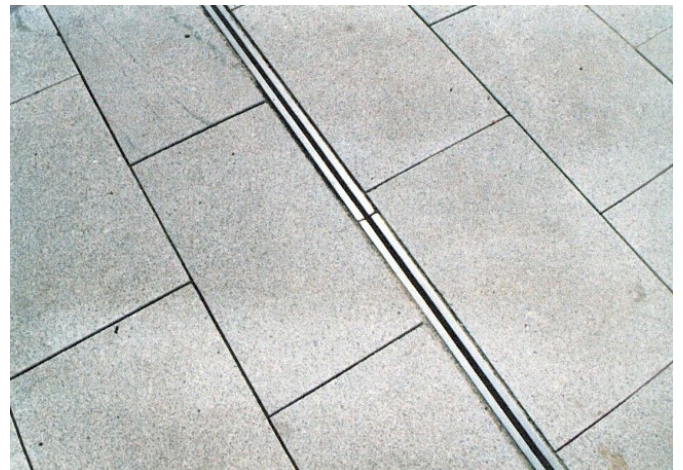
Abb. 21: Beispiel einer Schlitzrinnen-Entwässerung
