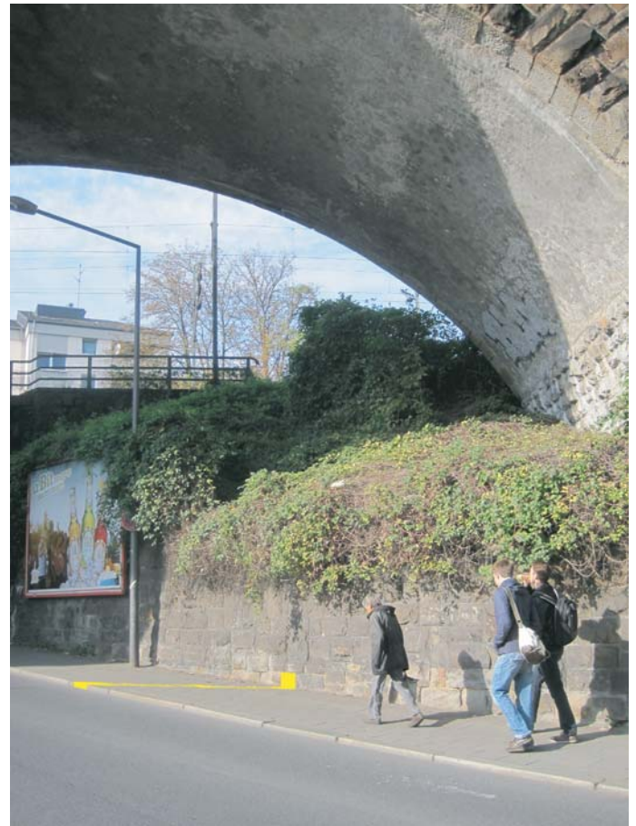
28_Eine Linie mit Schriftzug auf dem Bürgersteig verweist auf den Verlauf der Eisenbahnlinie [siehe auch die untere Abbildung]
