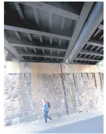
19_20_Zwischenraum der beiden unteren Stahlbrückenelemente diskreter Installationsraum für die Strahler des „Lichtraums“
