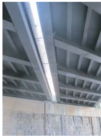
19_20_Zwischenraum der beiden unteren Stahlbrückenelemente diskreter Installationsraum für die Strahler des „Lichtraums“
