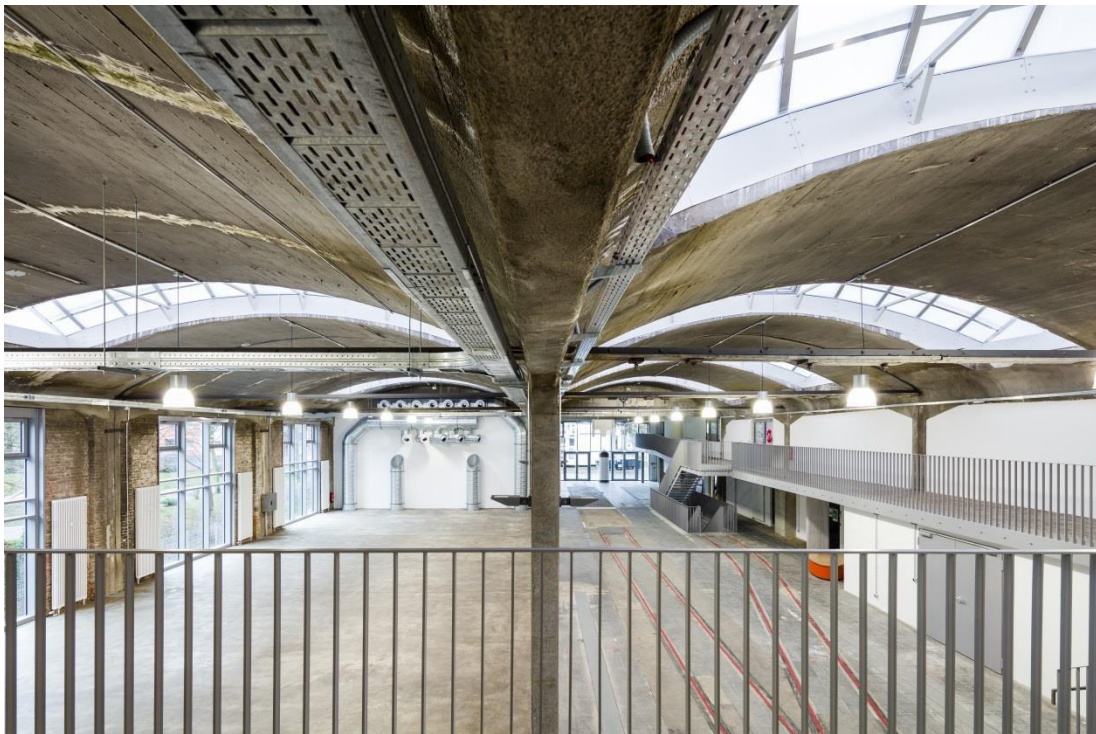
Die umgestaltete Wagenhalle von außen und von innen. Fotos: Peter Hinschläger.
