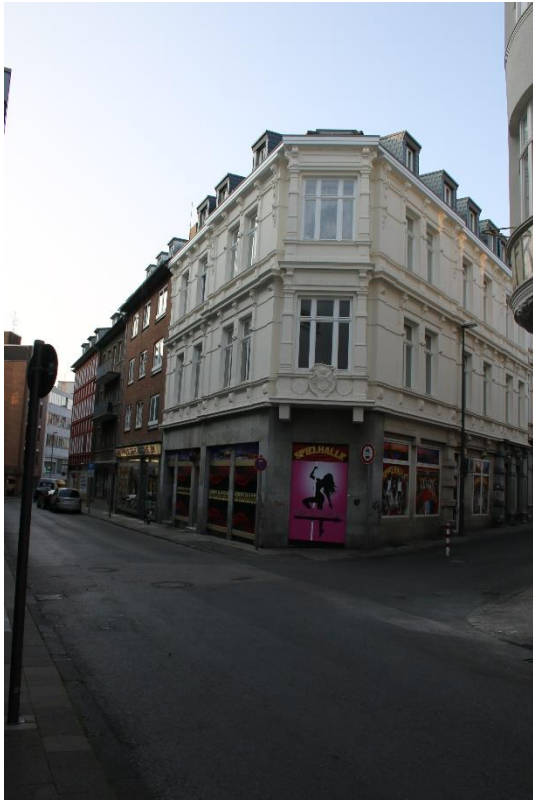
Abbildung 10: Mefferdatisstraße 8 Teilsaniertes Gebäude Quelle: Eigene Aufnahme
