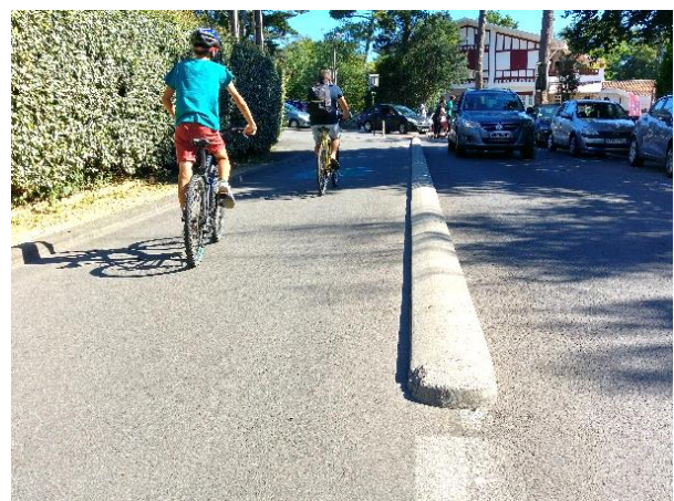
Abbildung 4: bauliche Trennung Radweg zur Fahrbahn
