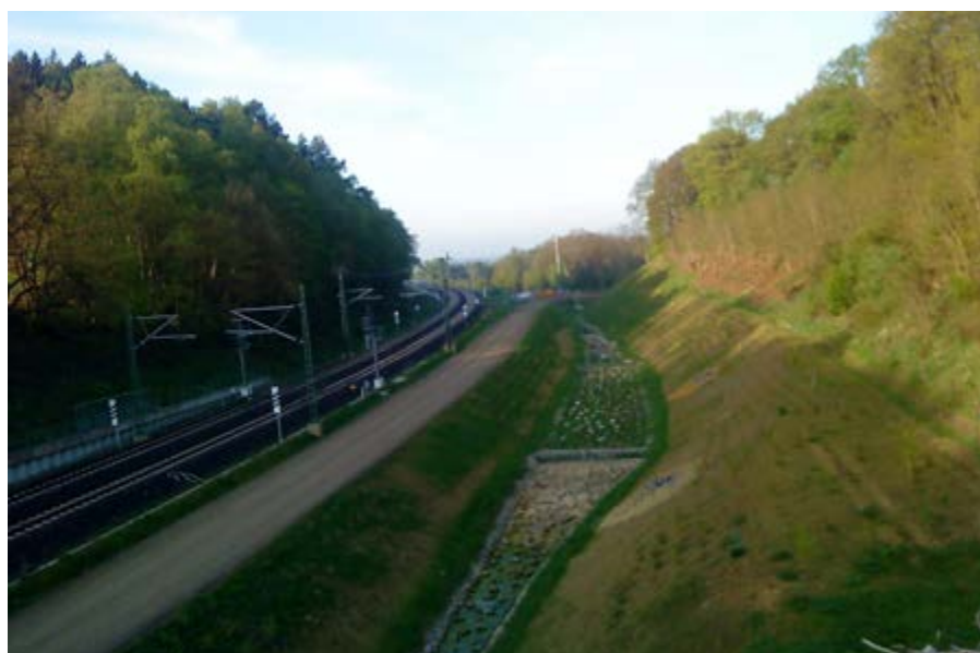
Bild 29: Blick auf Fläche 1 von der Fußgängerbrücke
