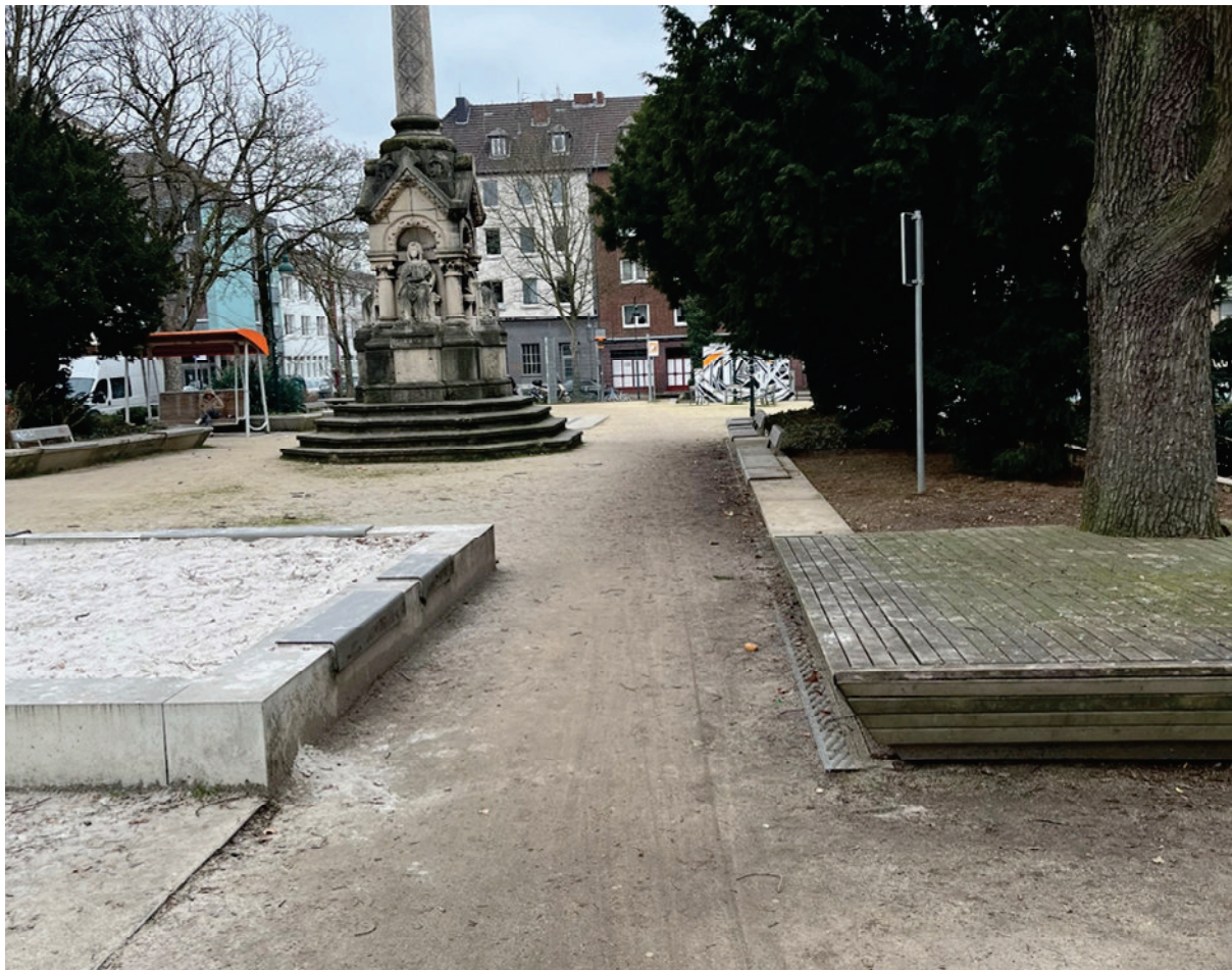
Abbildung 13 Wassergebundene Wegedecke Rehmpplatz, eingeschränkte Barrierefreiheit
