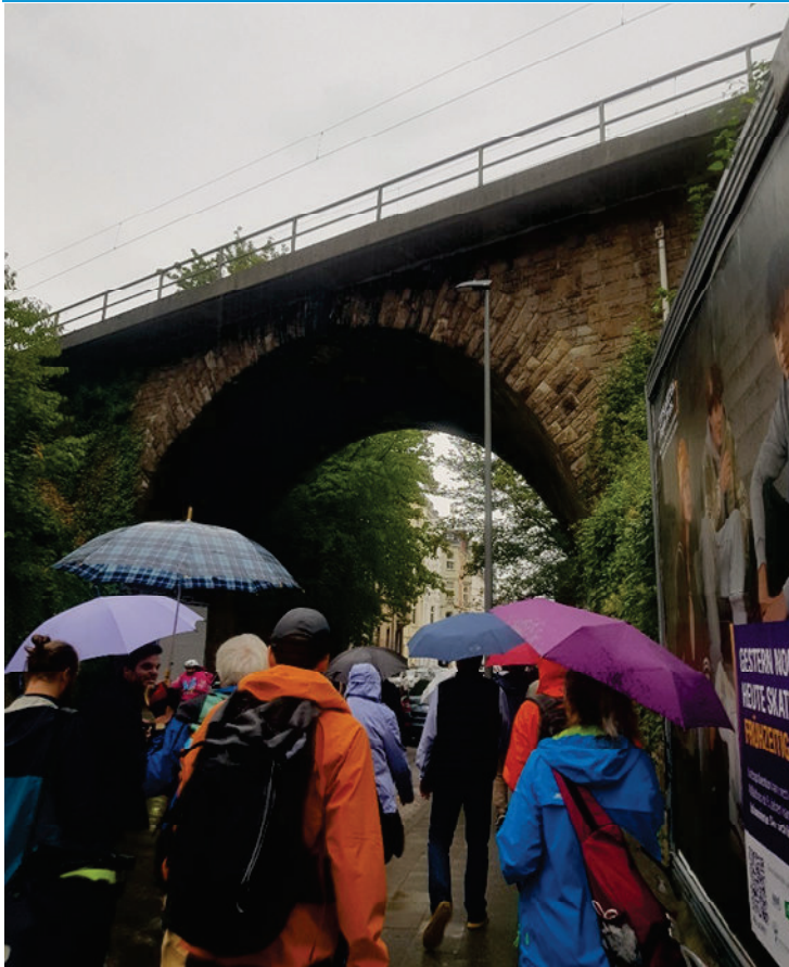
Abbildung 39: Unterführung an der Lochnerstraße
