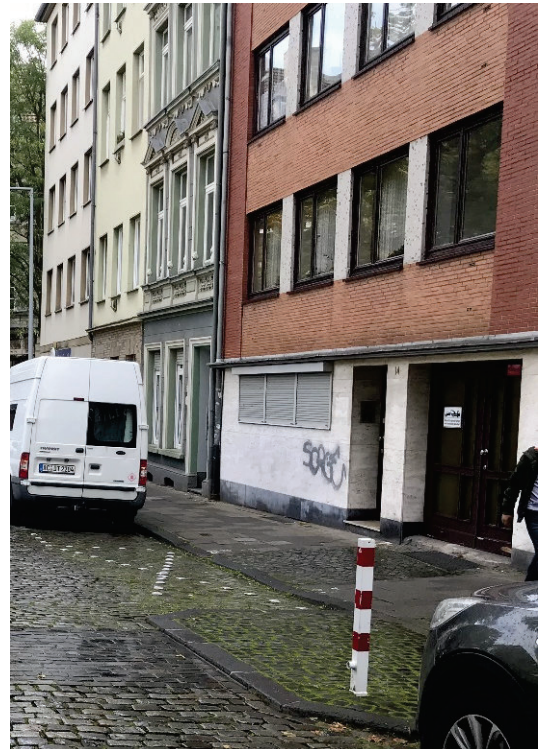
Abbildung 11: Querneigung und Gehwegabsenkung am Rehmplatz
