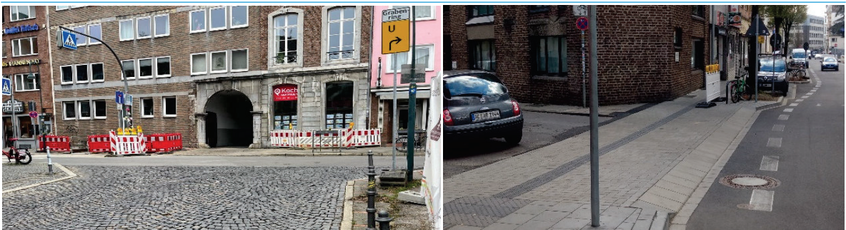
Abbildung 23: Einmündungsbereich an der Klappergasse (links), Gehwegüberfahrt Lothringerstraße (rechts)
