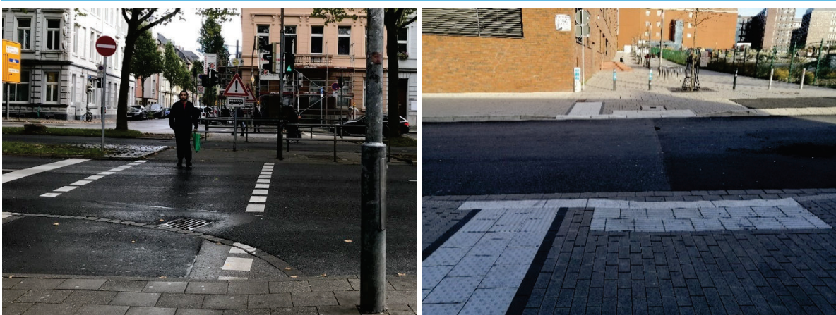
Abbildung 4: Beispiel fehlender differenzierter Bordhöhe (links) und Nullabsenkung mit Hochbord (rechts)
