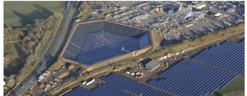
Quelle: Vojens Fjernvarme
